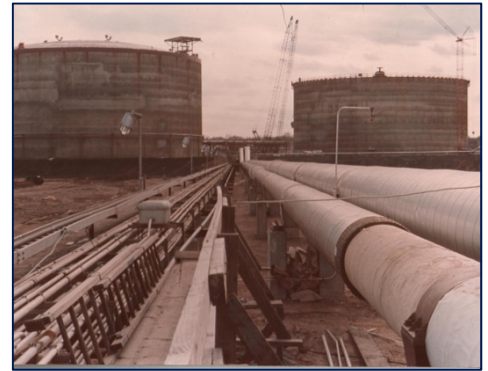
Two 1 Million Barrel LNG Plant
